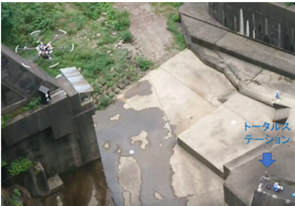
トータルステーションで追尾中の様子
